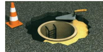
Amasar Sika® FastFix 138-TP con consistencia seca y preparar la capa base de la pieza a fijar.
