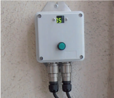
SISTEMA DE CONTROL DE LLAMADAS DE PLANTAS LANDING LEVEL CALL SYSTEM SYSTÈME DE CONTRÔLE DES APPELS D'ETAGE
